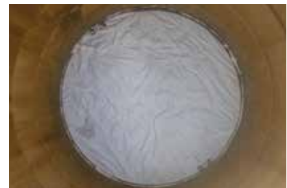
Sickerschacht fertig nacherüstet mit dem KALCHER SI – NACHRÜSTSYSTEM
